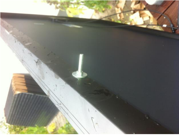
glidesikringskrue 1 pr. solcelle efter Würth anvis.
